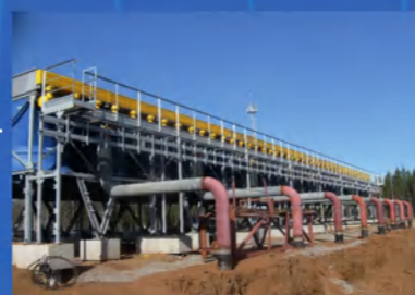
Эксплуатация АВГ 100МГ/3-6-20(С)/М КС «Новоприводинская»
